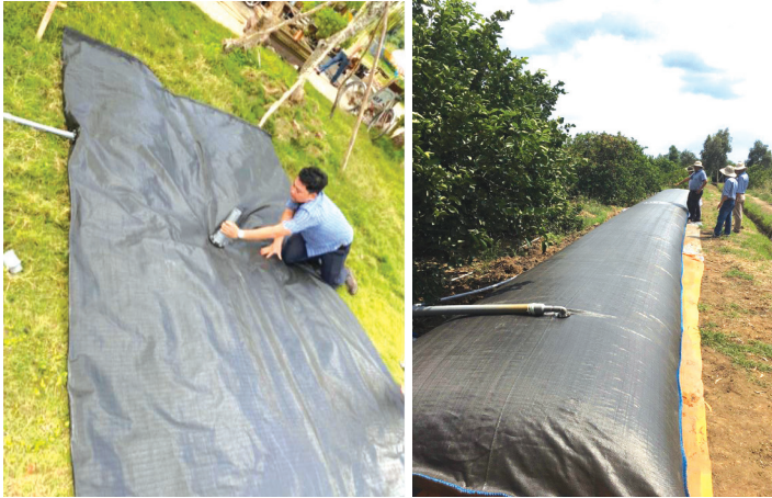
Hình 7. Lắp đặt các phụ kiện và bơm nước vào túi chứa nước
