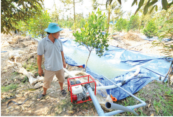
Hình 3. Trại chống thấm màng vườn cây bằng bạt PE
