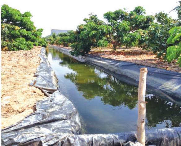
Hình 4. Trại chống thấm màng vườn cây bằng bạt HDPE
