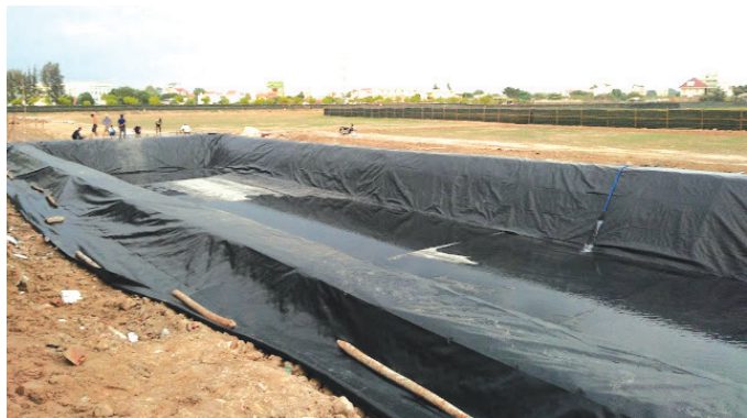
Hình 5. Hình minh họa chống thấm ao/hồ trích trữ nước ngọt
